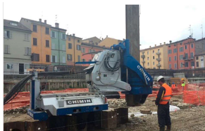
Spunting uten vibro (Kilde: WeBuild)
