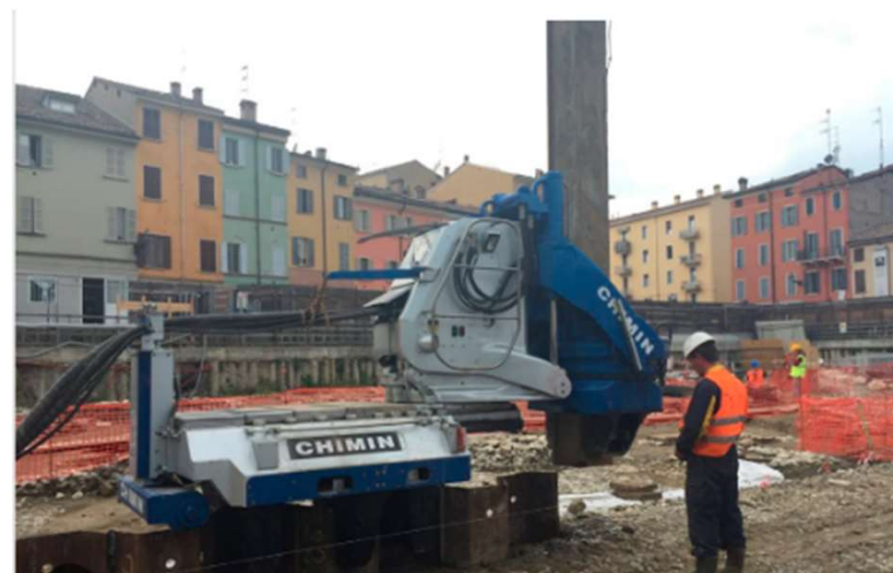
Spunting uten vibro (Kilde: WeBuild)
