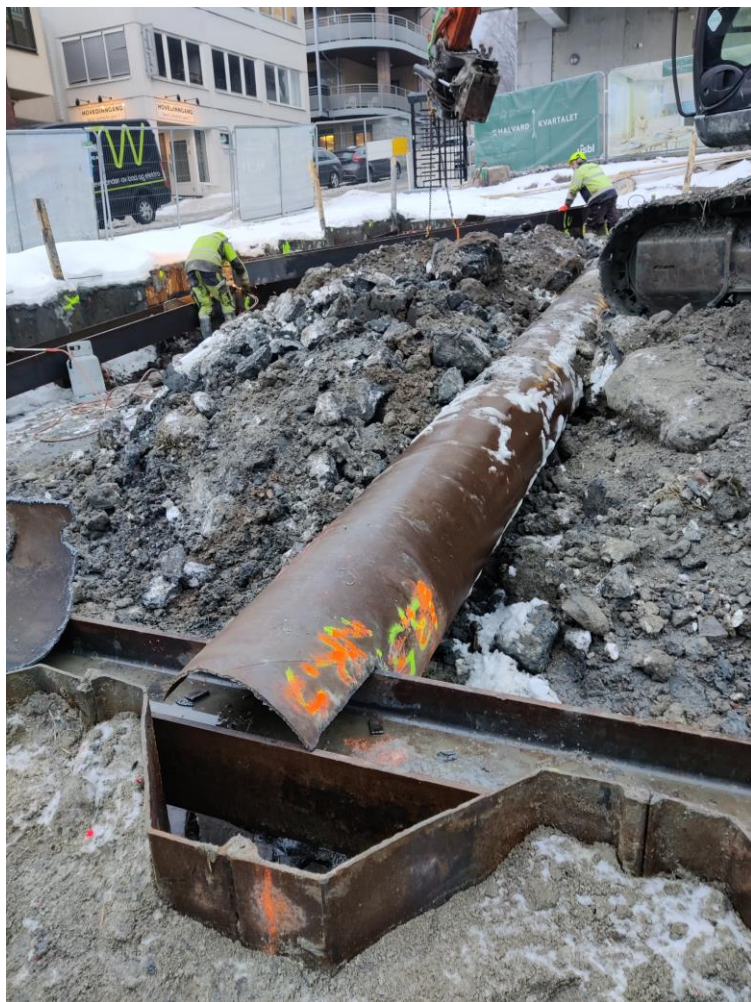
Innvendig avstiving av spunt med tverrstivere og hjørnestivere
