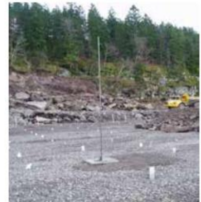
Figur 1-1- 4 Målestenger for setninger i grunnen under fylling (Foto: C. E. Dahl).
