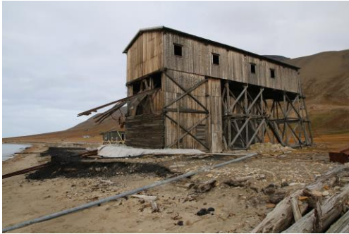
Taubanestasjonen in Hiorthhamn
