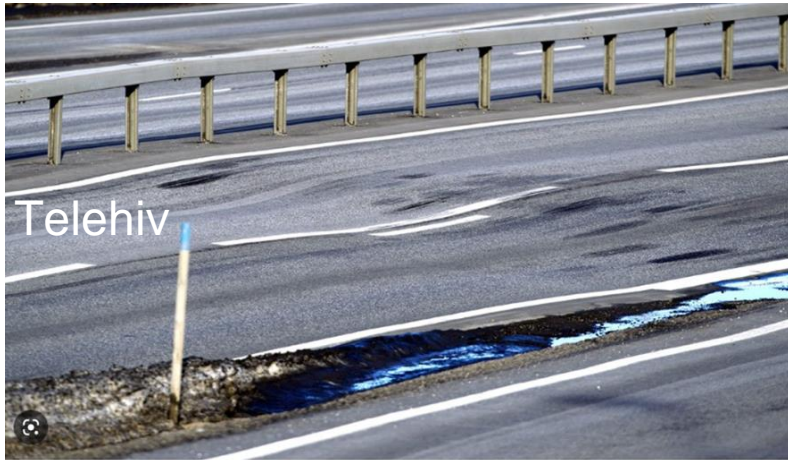
Ny motorvei – full av telehiv Frostsikring av veg
