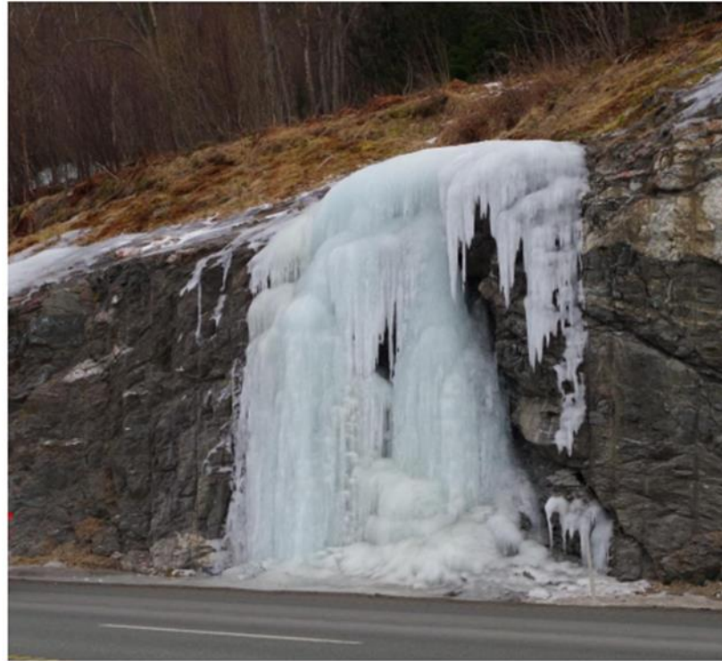
Frostsikring av veg
