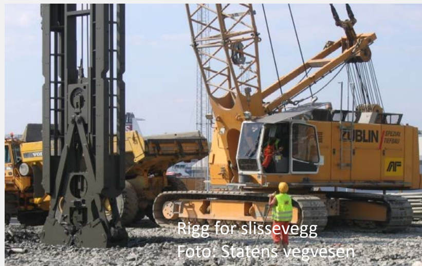
Rørspunt Foto: Entreprenørservice
